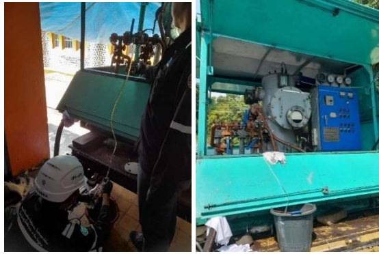
Gambar 5. Proses dari purifikasi minyak isolasi transformator
